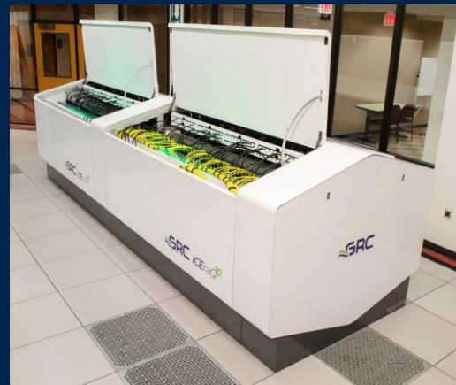
Immersion 250 kW per rack
