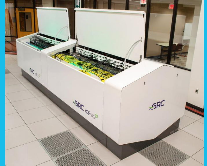
Immersion 250 kW per rack
